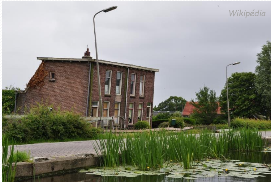
Deux exemples de tassements différentiels
