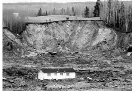
Exemple : plusieurs glissements rotationnels successifs
