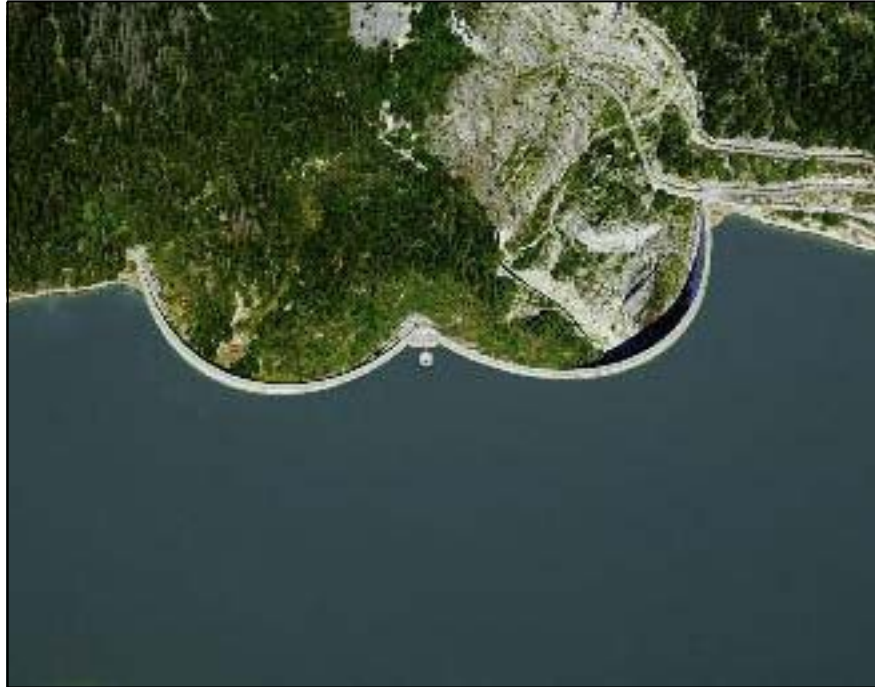
Barrage à double voûte de Hongrin (Suisse) - 240 MW
