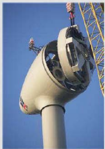
Montage d'une génératrice
