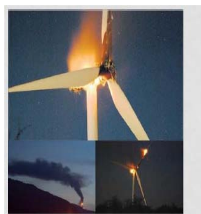
Eolienne en feu en Ardèche (10/2009)
