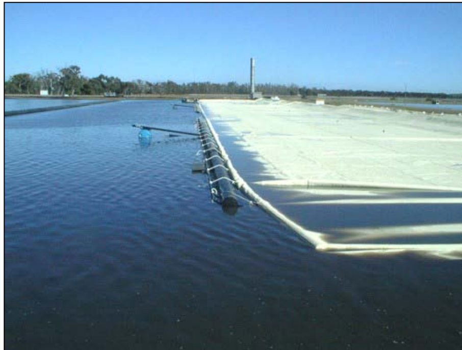
Couverture du lagon de traitement des eaux usées de Mooroopna, en Australie. http://www.gwwater.vic.gov.au/archive/infrastructure/moorwmf.asp .
