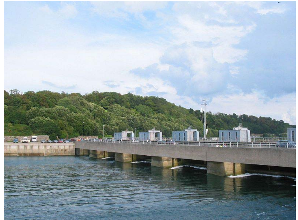
Barrage de la Rance (Ille-et-Vilaine) 240 MW (2 ème plus puissante au monde)
