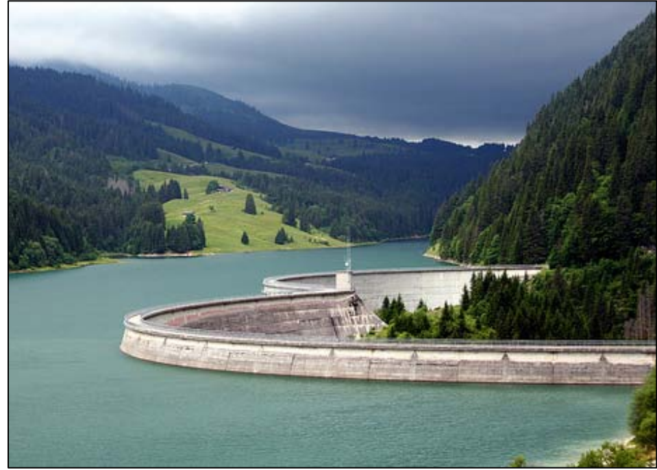
Barrage à double voûte de Hongrin (Suisse) - 240 MW
