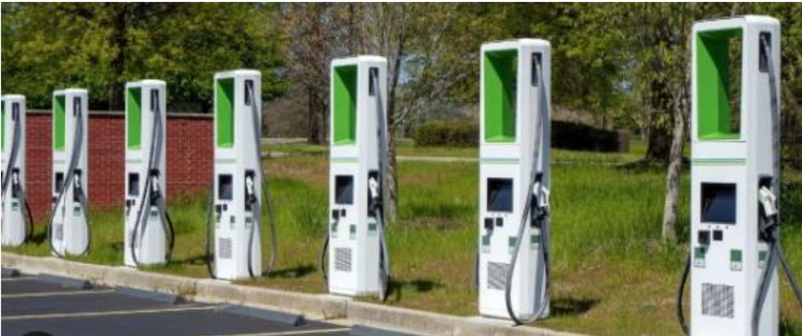
Figure 4 : Projet des borne IRVE double alimentation 22 kVA
