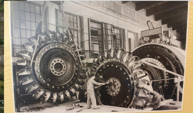
Les roues PELTON sont accouplées à l'alternateur
