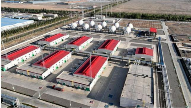
L'installation d'électrolyse de Sinopec, à Kucha / Image : Sinopec, gouvernement de Chine.
