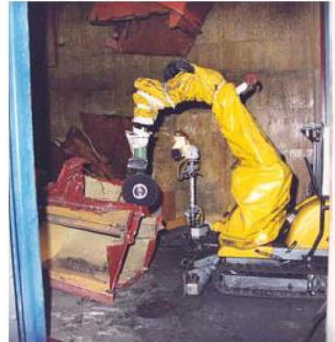
Porteur BROKK et bras équipé pour une découpe à la disqueuse
