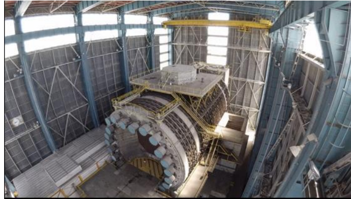
Vérification de la structure du Réacteur G2 avec un drone
