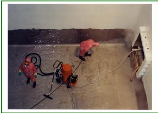
Assainissement à l'eau sous pression et aspiration des effluents
