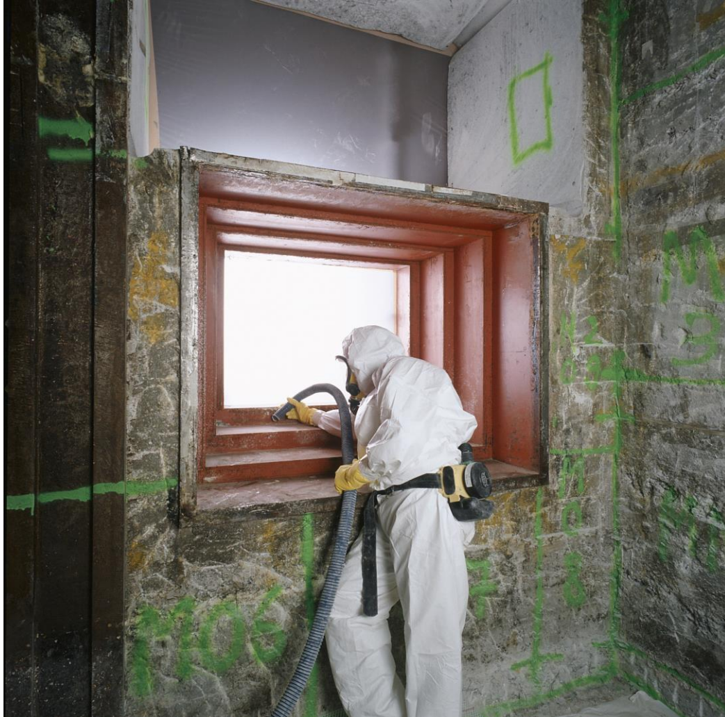
Assainissement d'une cellule au CEA Fontenay-aux-Roses
