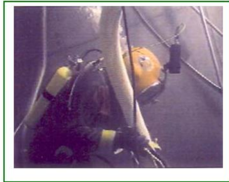
Plongeur aspirant des boues en fond de piscine
