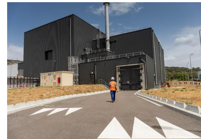
Installation DIADEM – Installation neuve pour entreposer les déchets de moyenne activité hautement irradiants issus du démantèlement des installations du CEA 48
