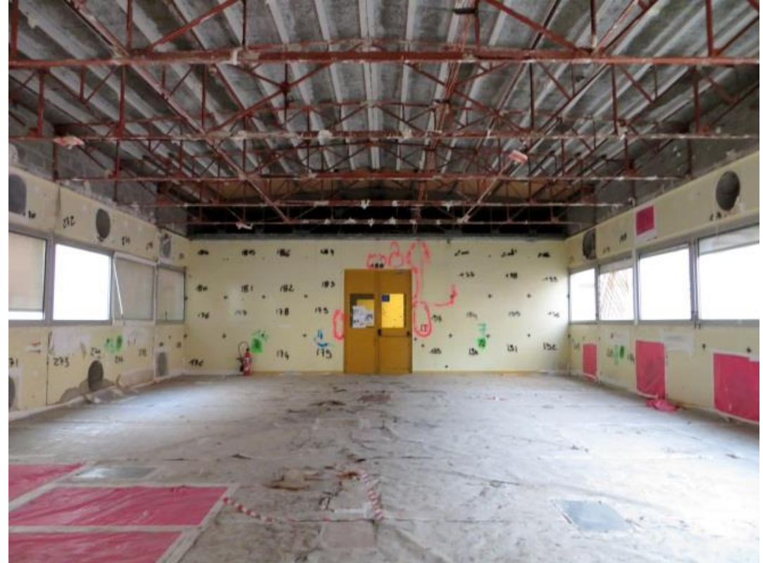
Cellule en cours d'assainissement final à l'INB 49 au CEA Saclay
