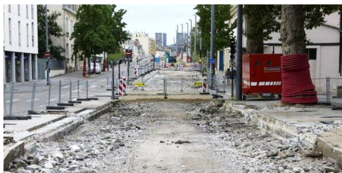
Figure 1 : exemple de travaux avant la coulée du radier en béton
